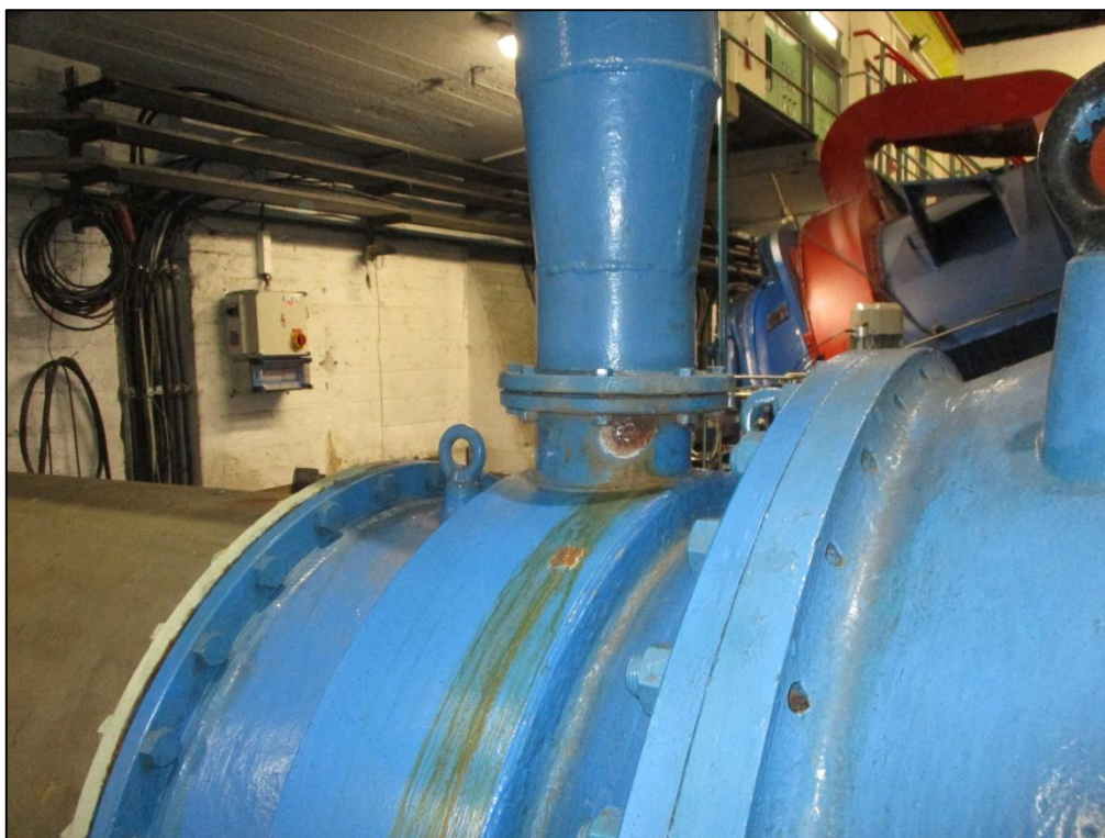
Obr. 1 Provizorně opravené prokorodované zavzdušňovací potrubí pravého KU.
